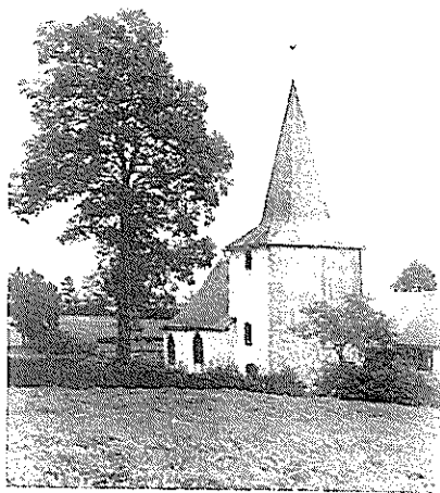
119bis. LANZERATH. Chapelle St-Joseph. Construction antérieure.
